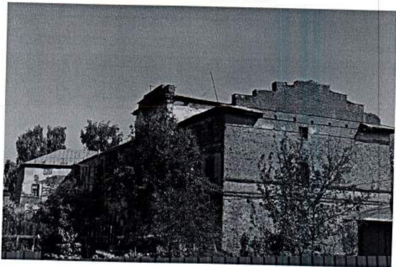
Точка фотофиксации № 8. Общий вид с западной стороны.
