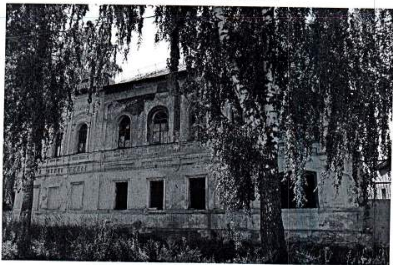
Точка фотофиксации № 10. Общий вид с северо-восточной стороны.
