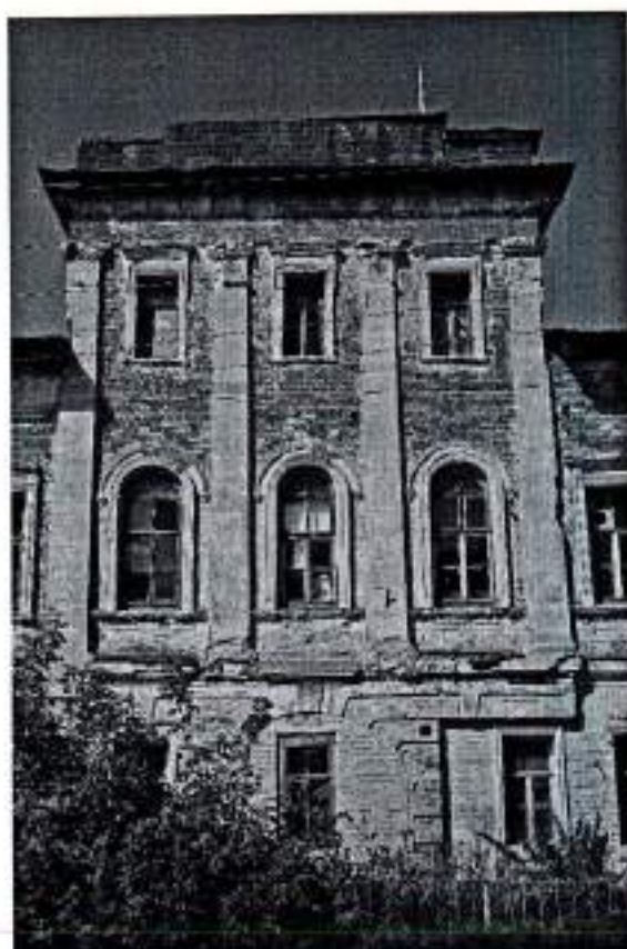
Точка фотофиксации № 5. Фрагмент юго-восточного фасада.
