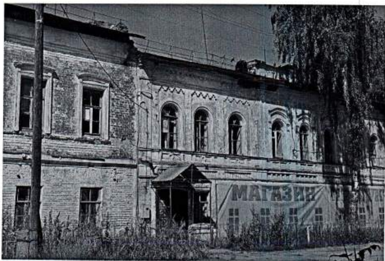
Точка фотофиксации № 3. Фрагмент юго-восточного фасада.
