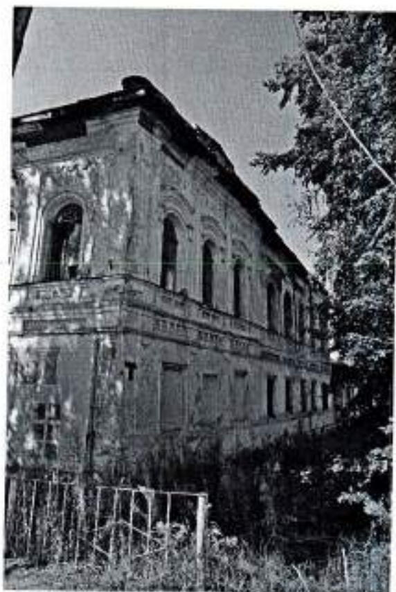
Точка фотофиксации № 9. Фрагмент северо-восточного фасада.
