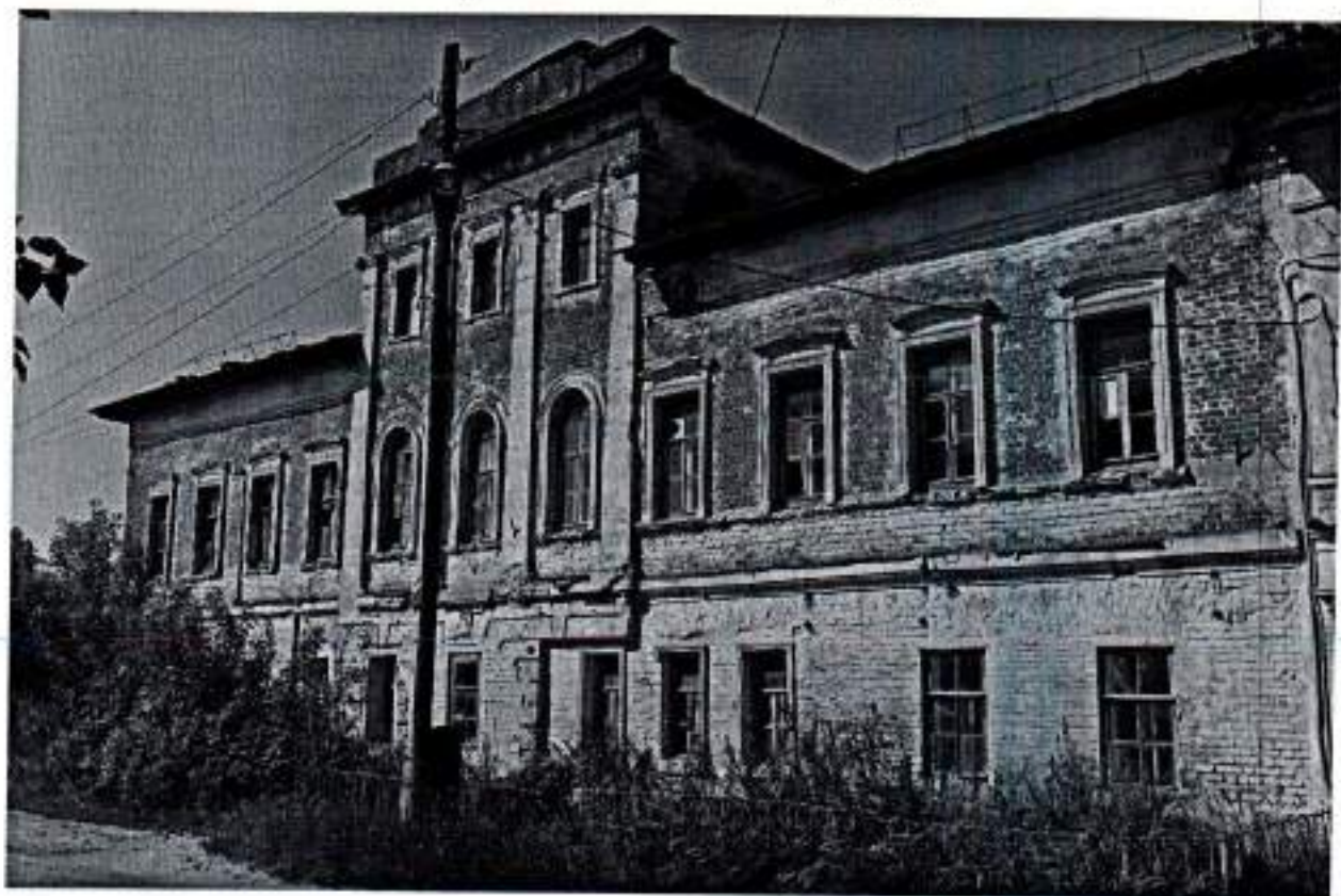
Точка фотофиксации № 4. Фрагмент юго-восточного фасада.
