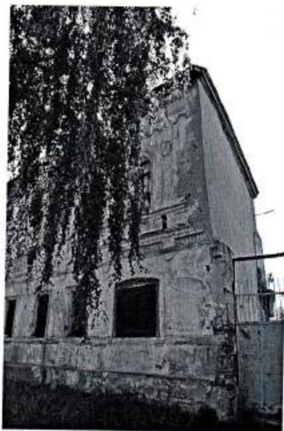
Точка фотофиксации № 11. Фрагмент северо-восточного фасада.
