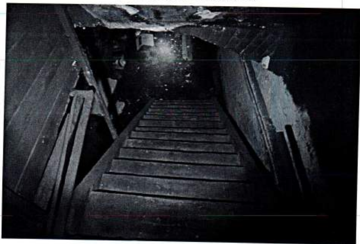
Точка фотофиксации № 12. Фрагмент интерьера. Подвал. Внутренние помещения. Лестница
