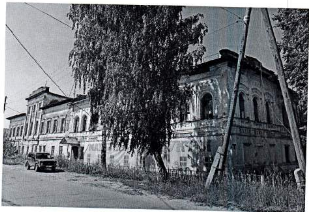
Точка фотофиксации № 1. Общий вид с юго-восточной стороны.
